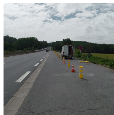
Pose de balises
