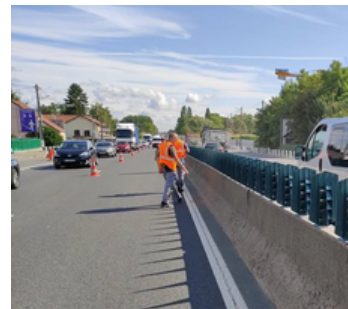
Pose d'obstacles sur le terre-plein central
